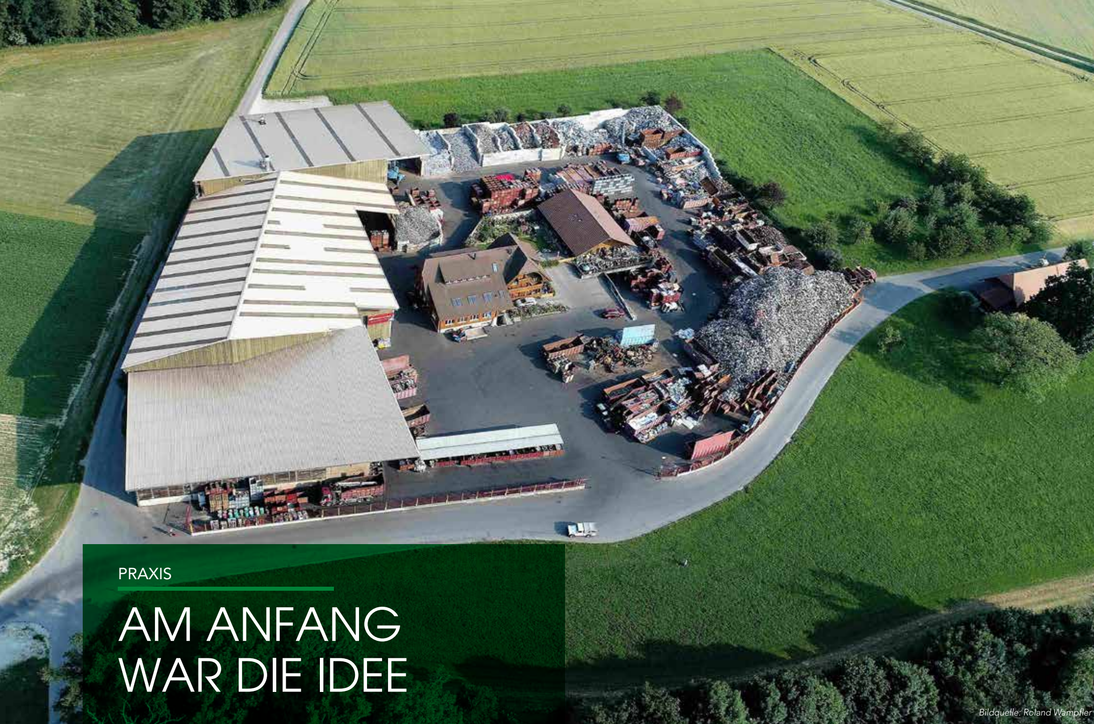
Der Standort der Bülmann Recycling AG in Münchenwiler (Schweiz).
