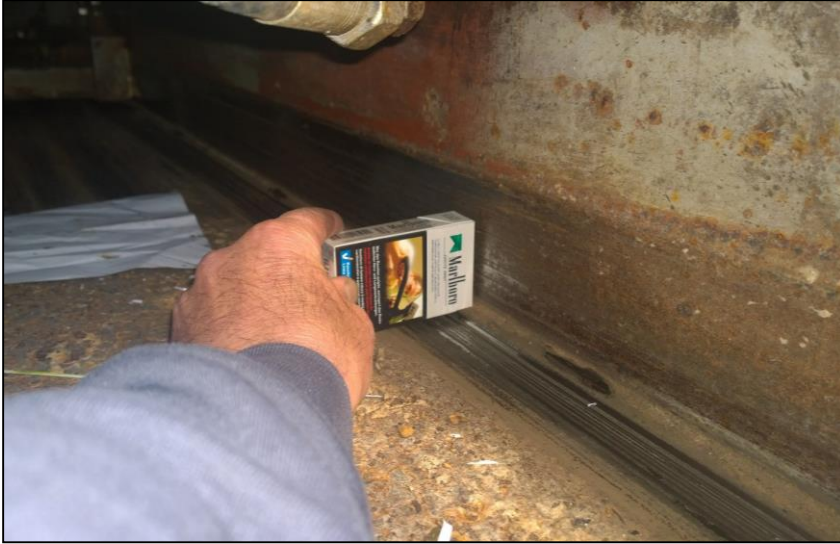
Eingelaufener Boden
