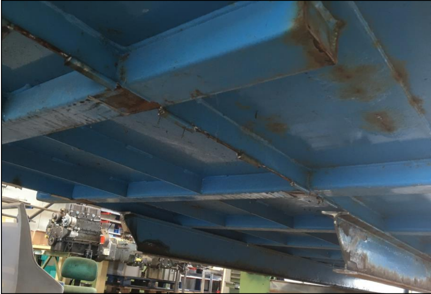
Reparatur eines verzogenen INP-Profiles
