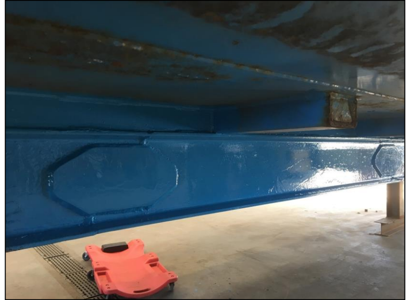
Reparatur eines verzogenen INP-Profiles
