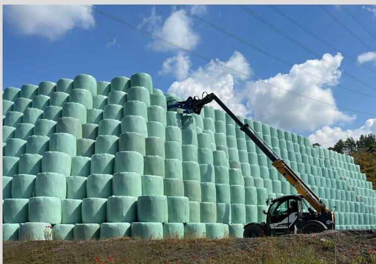
*Praktische Umsetzung der Zwischenlagerung von Abfall: Ballenlager durch die Firma Prestaball.*
