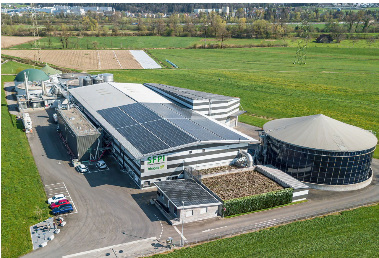
SwissFarmerPower in Inwil: kombiniert Trocken- und Nassvergärung
